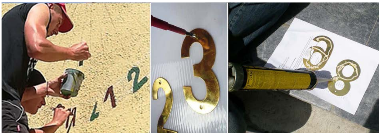
■ Слика 22. Бројке се могу насликати (99), зашрафити или прилепити, директно на зиду или на плочу која се потом фиксира на зид.
