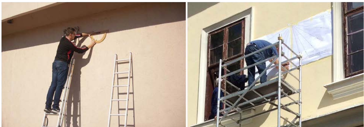
■ Слика 21. Часовне линије и бројчаник могу се обележити директно на зиду (лево – ОШ „Бранко Радичевић”, Крушевац, 2015) или помоћу шаблона (десно – Прва гимназија, Крагујевац, 2019)
